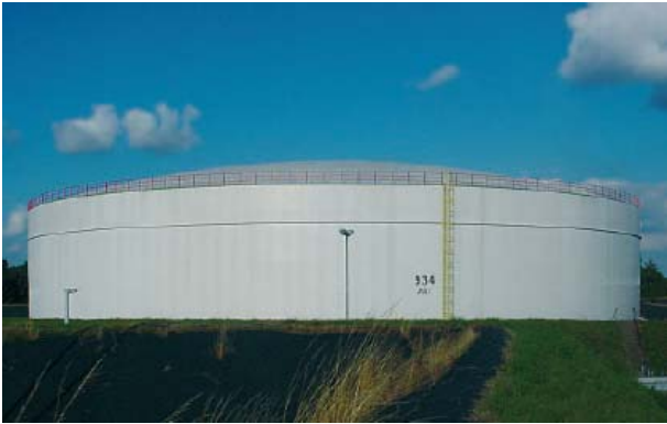
Общий вид резервуара
