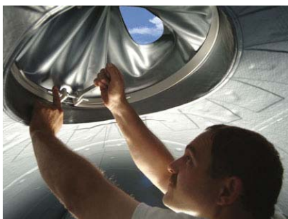
Установка уплотнения люка
