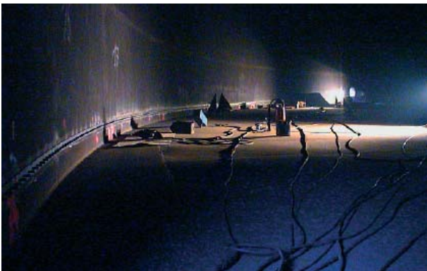
Установка системы крепежа вкладыша
