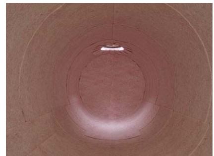
Установка промежуточного слоя
