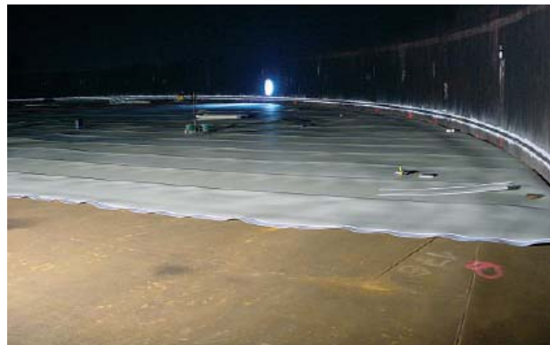
Установка проницаемого мата (спейсера)
