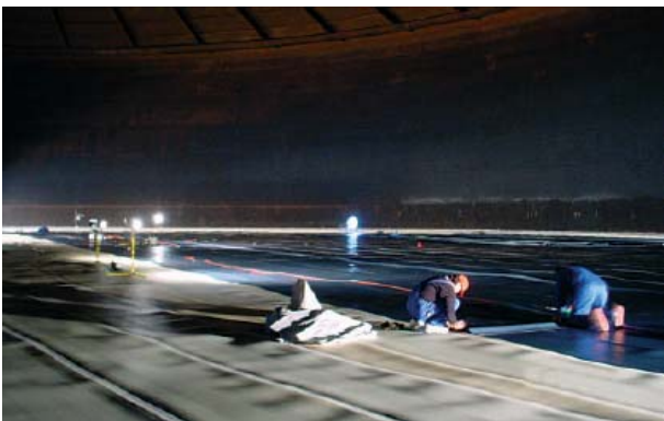
Установка эластичного вкладыша
