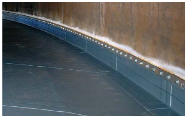
Вакуумный тест резервуара
